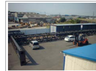
門型標識柱 仮組風景
